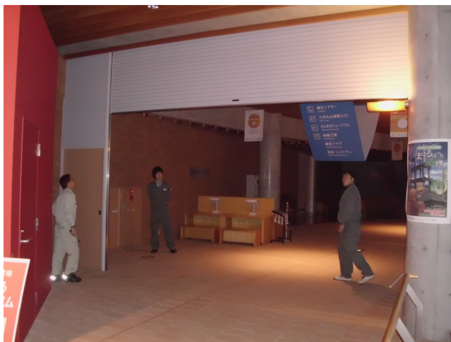
縄文時遊館防火シャッターの作動点検
