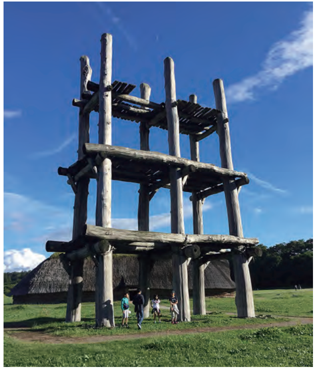
図28 復元大型掘立柱建物の現況
