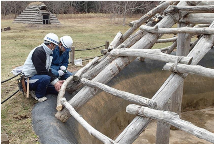
脱落した木材の補修
