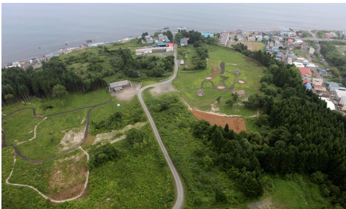
整備後の航空写真
