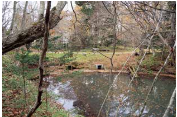
写真71 土橋(無名川架設)(南東より)
