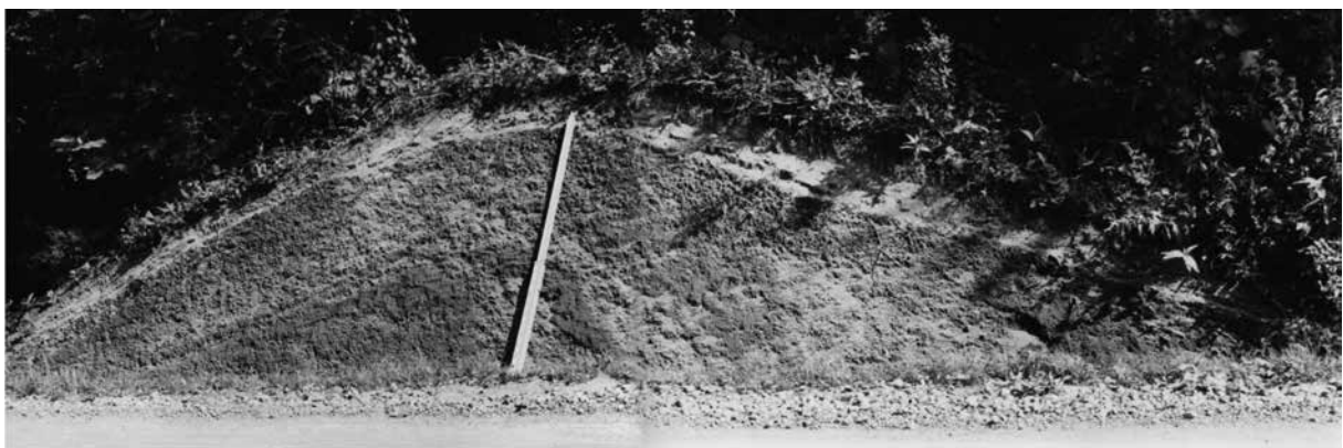
写真22 キウス2号周堤墓周堤（図19「土籬A部」）断面（1965年6月）（西より）※2カット合成
