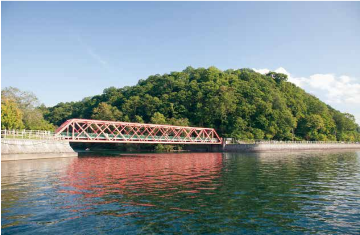
写真5 市指定文化財 建造物 山線鉄橋
