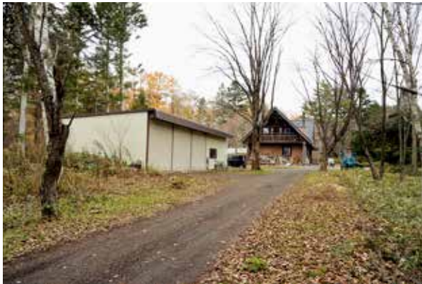
写真70 住宅・倉庫及びエントランス舗装(西より)
