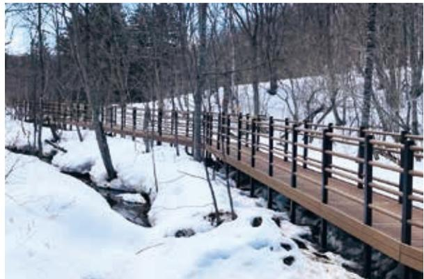
写真29 園路「高架木道」の事例(4) (西岡水源池: 鋼材+再生木材)
